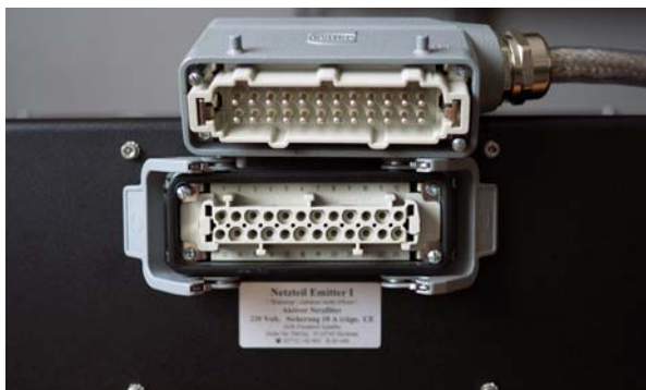
Eine Industrie-Steckverbindung von Harting stellt den Kontakt zwischen Netzteil und Verstärker sicher
